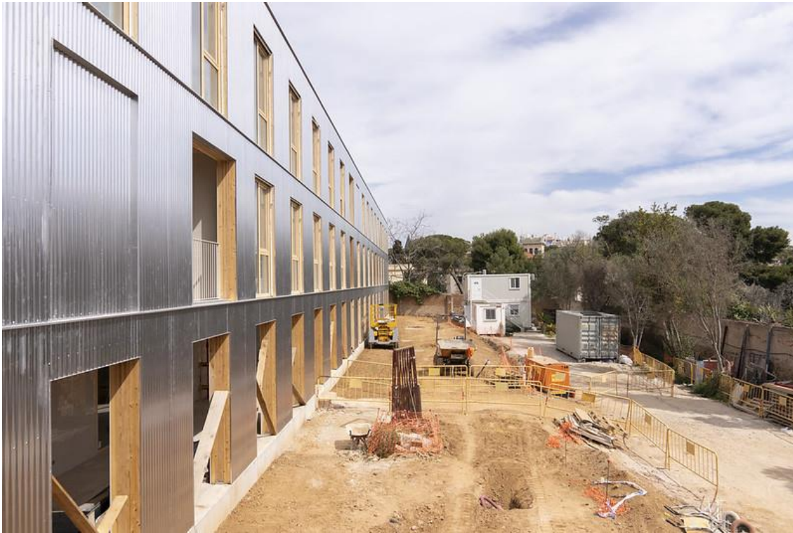
Obras del Servicio Integral Sarrià // Ajuntament de Barcelona
